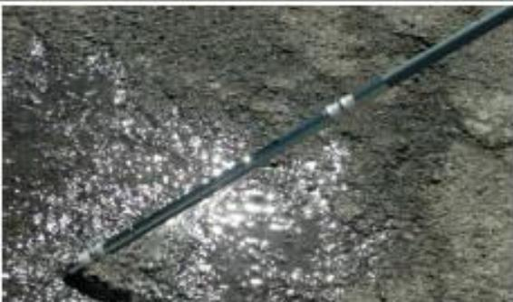
После окончания инъекционных работ незамедлительно очистите трубку и пакер водой.
